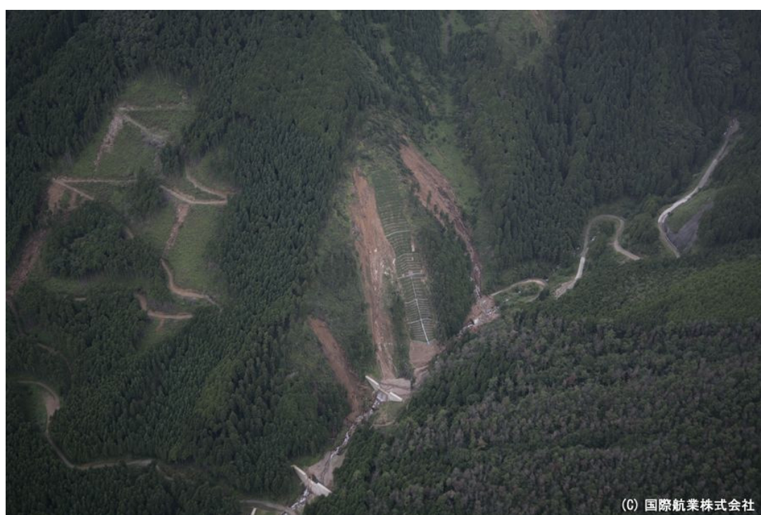
図 4.5 谷止工，山腹工と崩壊地の状況 5)
