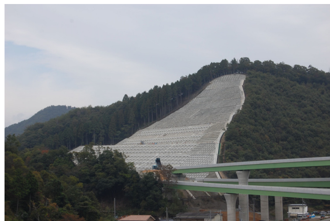
図 4.33 完成後の斜面（平成 21 年 10 月）
