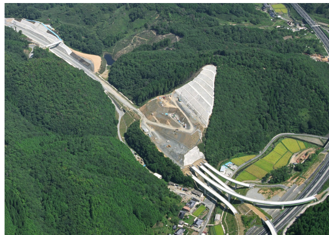
図 4.28 現地航空写真（平成 20 年 9 月）
