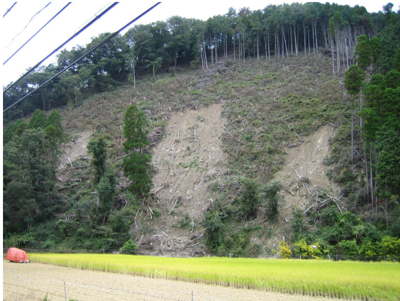
図 2.3 平成 18 年 7 月豪雨によって発生した斜面崩壊の事例
