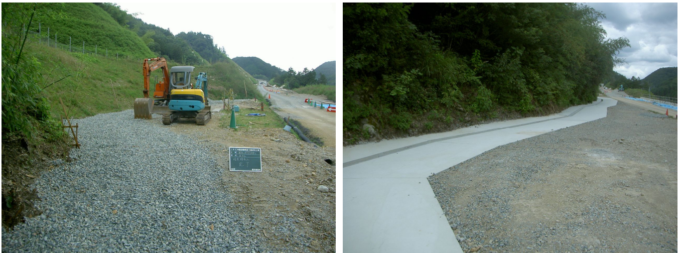
図 4.39 排水対策工施工完了
