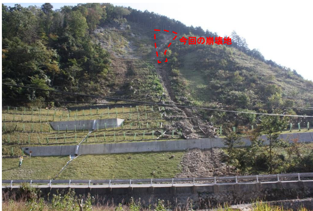
図 4.20 崩壊斜面状況
