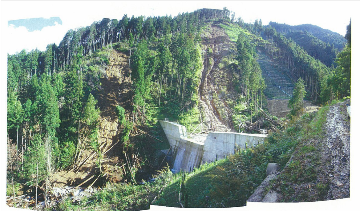
図 4.6 斜面下部から眺めた谷止工，山腹工と崩壊地の状況 4)
