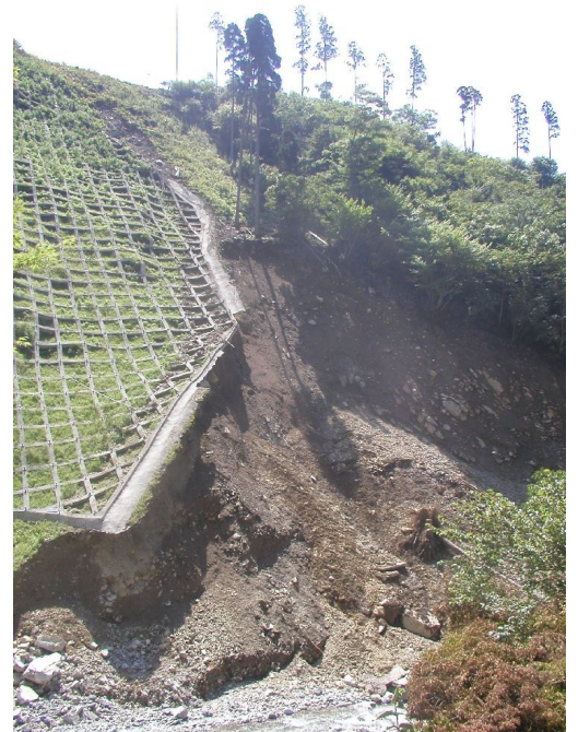
図 3.36 流水の衝撃部付近の状況
