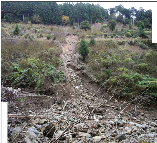
図 3.45 下流付近の斜面崩壊状況 (撮影方向⑤)
