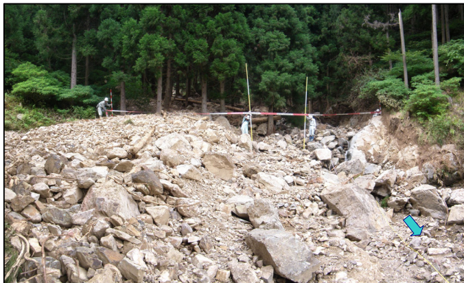
図 3.47 中下流付近土砂堆積状況 4) (撮影方向⑦)
