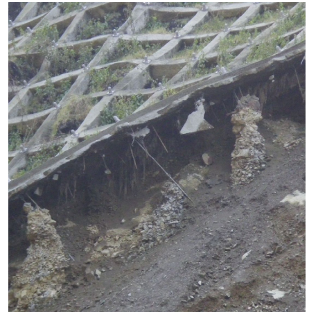
図 3.33 鉄筋挿入工の状況 4)
