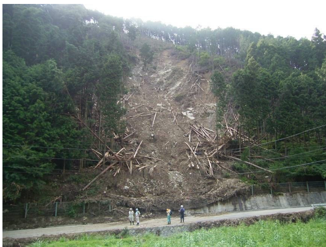
図 3.13 正面から見た崩壊地の状況
