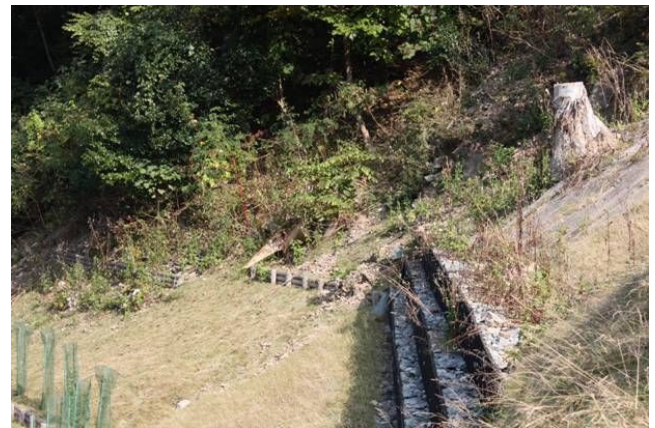
図4.15 鋼製砕土留工
