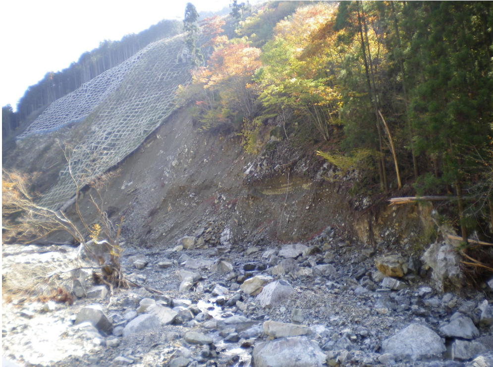
図 3.28 下流側からみた崩壊状況
