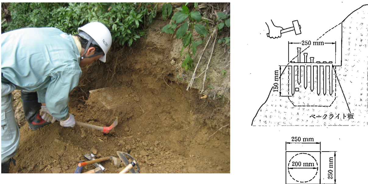
図 5.4 ネイルサンプリングの状況
