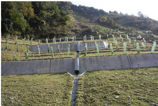
図4.14 コンクリート土留工と水路工
