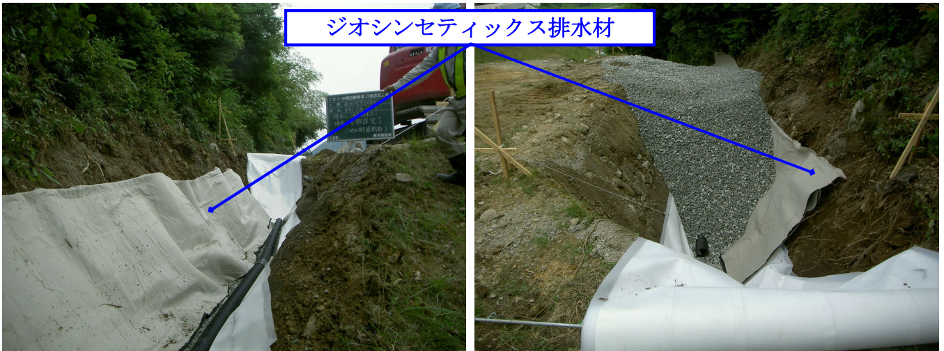
図 4.38 排水対策工の施工状況
