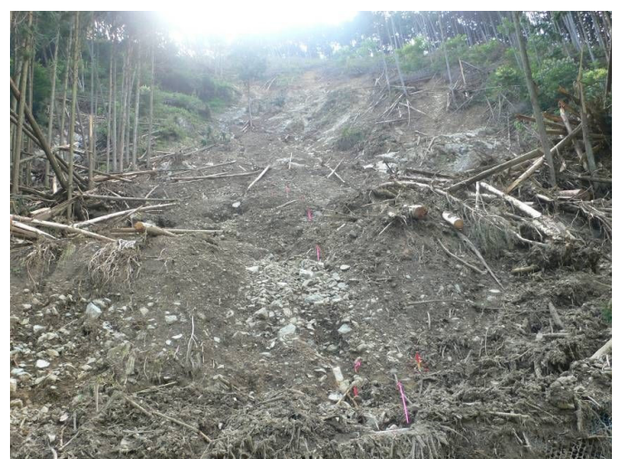
図 3.14 下から見た崩壊地の状況
