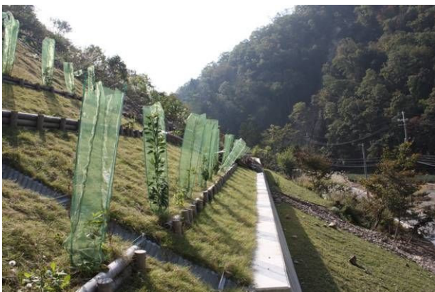
図4.16 柵工と植栽工
