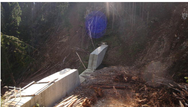
図 4.9 谷止工と山腹工の状況
