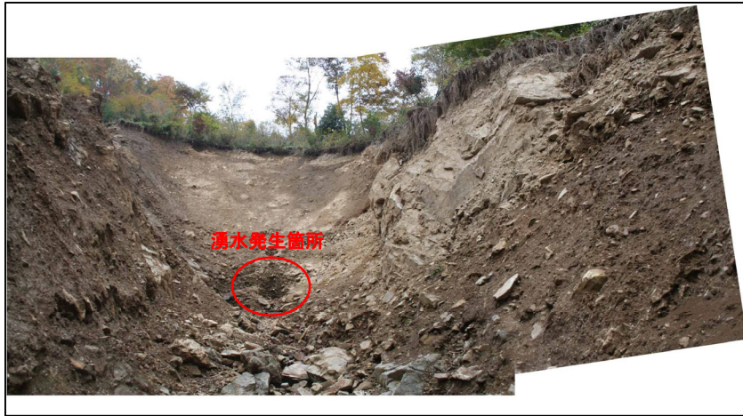
图 3.50 大規模斜面崩壊状況近景（撮影方向⑩）
